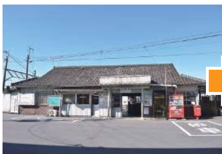
日野駅は老朽化が進み、部材の腐朽や破損がひどい状態
